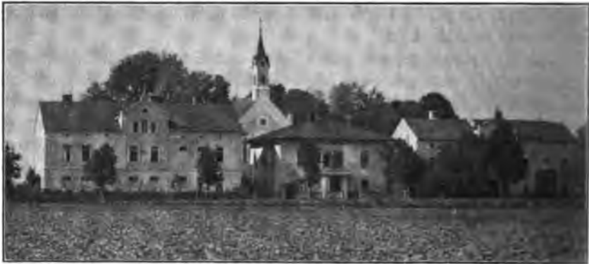
Bild 101. Das St. Franziskus-Haus in Altdötting.
